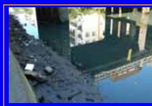
下流から9~11 km地点の堀川では、側岸がヘドロなどの堆積によって、河床が高くなっている
